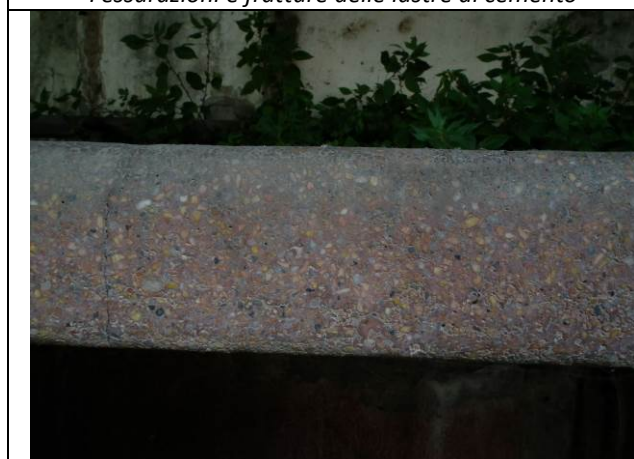
Decoesione della matrice cementizia
