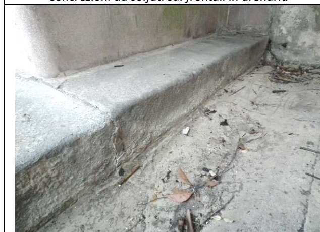
Fenomeno di decoesione e scagliatura dell'arenaria
