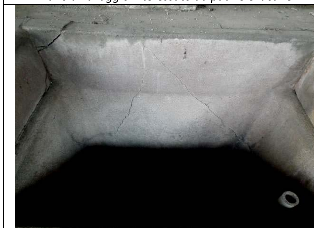
Fessurazioni e fratture delle lastre di cemento
