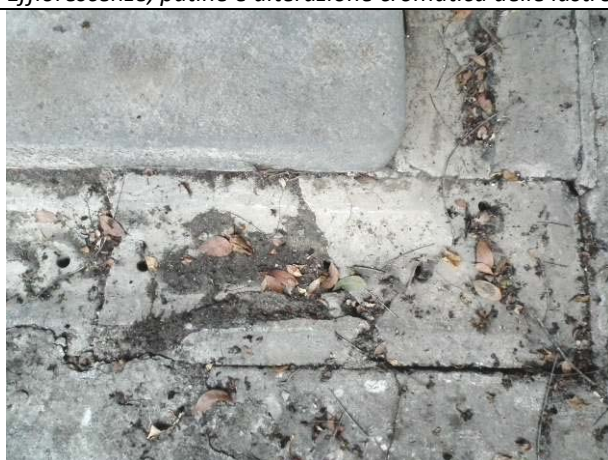
Rottura dei chiusini di cemento
