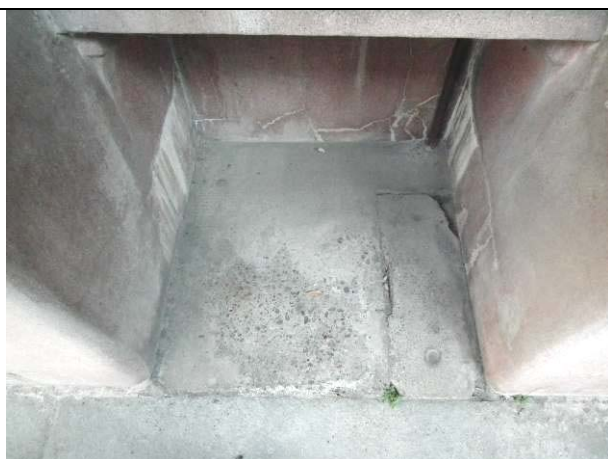
Efflorescenze, patine e alterazione cromatica delle lastre
