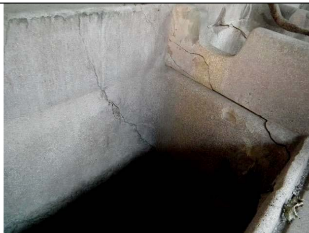
Fessurazioni e fratture delle lastre di cemento
